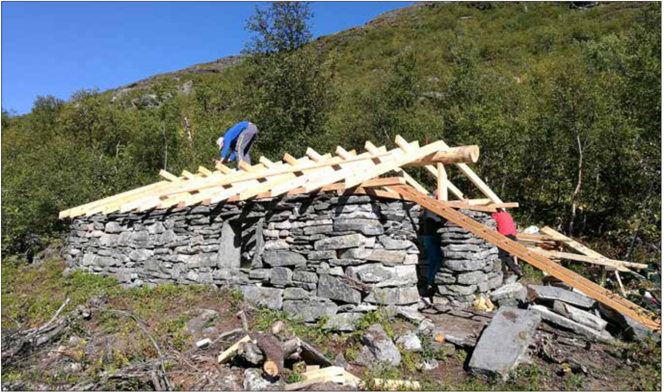
For at prosjektet skulle vere overkommeleg både praktisk og økonomisk, vart det lagt eit «moderne» sperretak på murane. Materialar og utstyr vart frakta frå Brønnhøbrøstet ned på Aurstølen med helikopter. Terje Utigard (bildet) med fleire vart hyra inn for å få tømrararbeidet fort unna. Opphavleg hadde det nok vore eit tak av same type som på Botnasetra s. 225. T.h. for døra stod ei nedramla grue. (Foto Hans Erik Oppigard)
