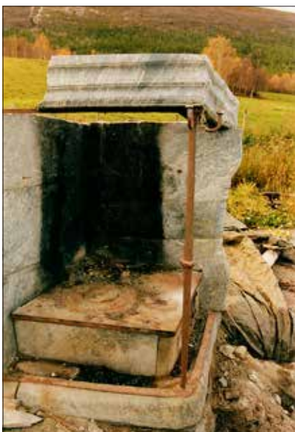
To gruer i hus som er under riving (på Otta?). Her er århellene plassert litt oppfrå golvet. (Foto utlånt av Tor Einbu)
