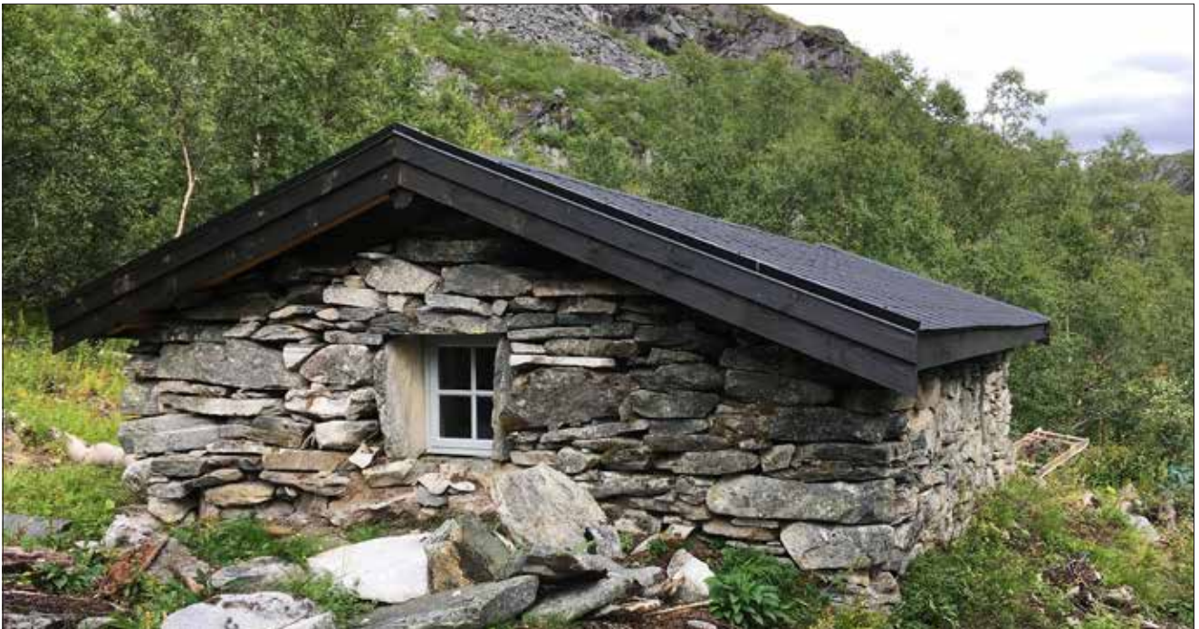
Torstein Oppigard laga, og sette inn, to nye vindu med 4 og 6 ruter. Med shingeltak, vinds kier, ny dør og alt synleg trevirke beisa, var prosjektet ferdig. (Foto Bjørn Austigard 2018)
