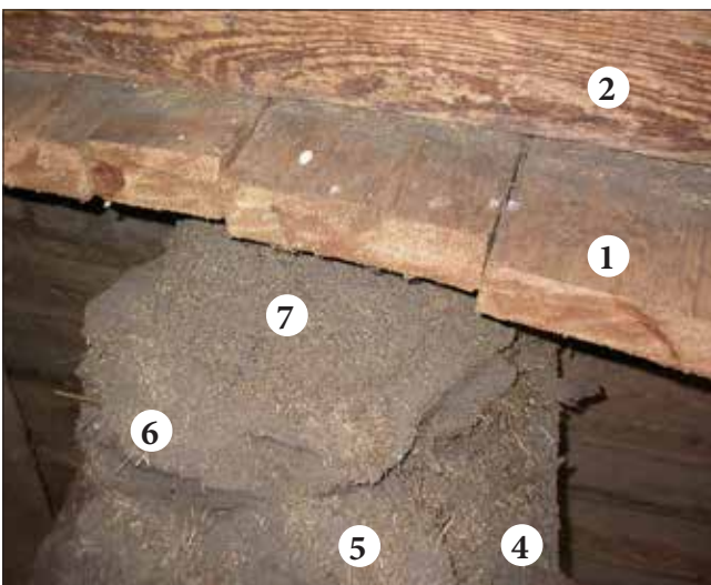
Trøskargolvet på løa i Oppigard var bygd opp i fleire lag slik som vist på skissa: (1) Sjølvje trøskargolvet var 5 cm tjukt og felt inn i vegg (2). (3) er golvåsane som held golvet oppe. (4) undergolv som held «isolasjonen» på plass, dvs. 3 cm tjukke bord, (5) er to lag (brukt) never, (6) to lag med 7-8 cm tjukke torver der grassida snudde ned, og oppå der (7) agner og rusk frå trøskinga.
