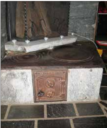
Århella på bildet over er montert i fronten. Kampen jernstøperi AS var etablert 1865, så døra er yngre enn det. Eit moderne omsnrør er montert inst i grua slik at det kan fyrast under århella. (Foto Tor Einbu)
