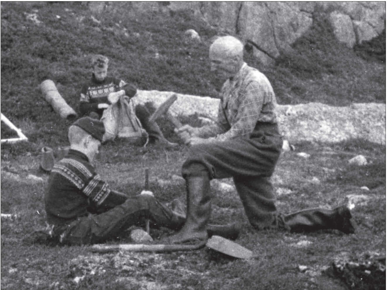
Hyttebygging bak Middagshaugen 1958. Far slo ein omgang ('ei heite') med feiselen, og så kvilte han. Eg berre snudde boren. (Foto Sverre Berg)
