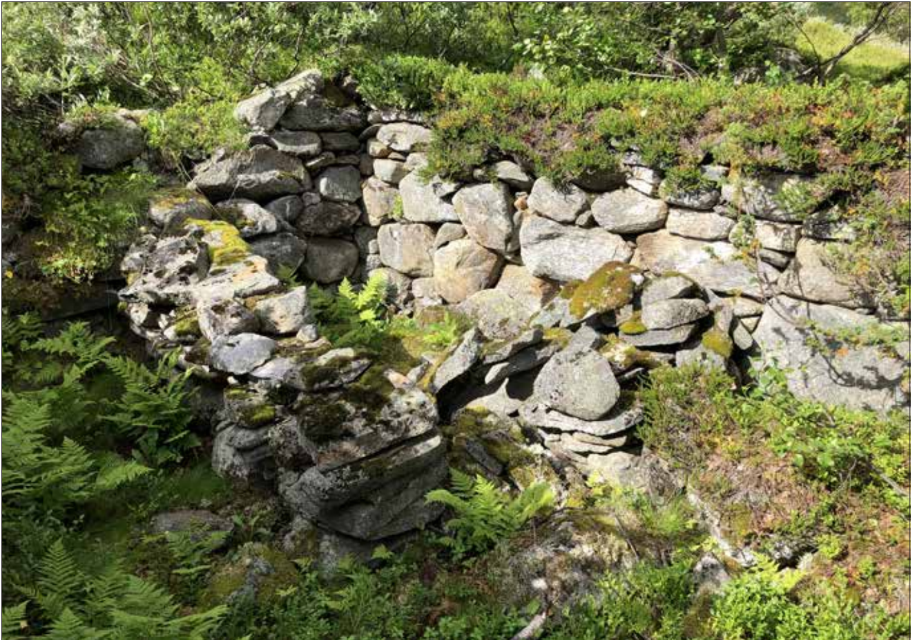
Den andre seterbua i Gravdalen er også graven inn i bakken. Her er restar etter ei grue (?) og ein mur som kanskje var sett der for å halde taket oppe. Ved inngangen veks mykje bjørk.
