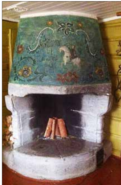
Denne grua har århelle av kleberstein og berre to kokehol. Fyringa er nede ved høgre vangen og det var nokså vanleg. (Foto Tor Einbu)
