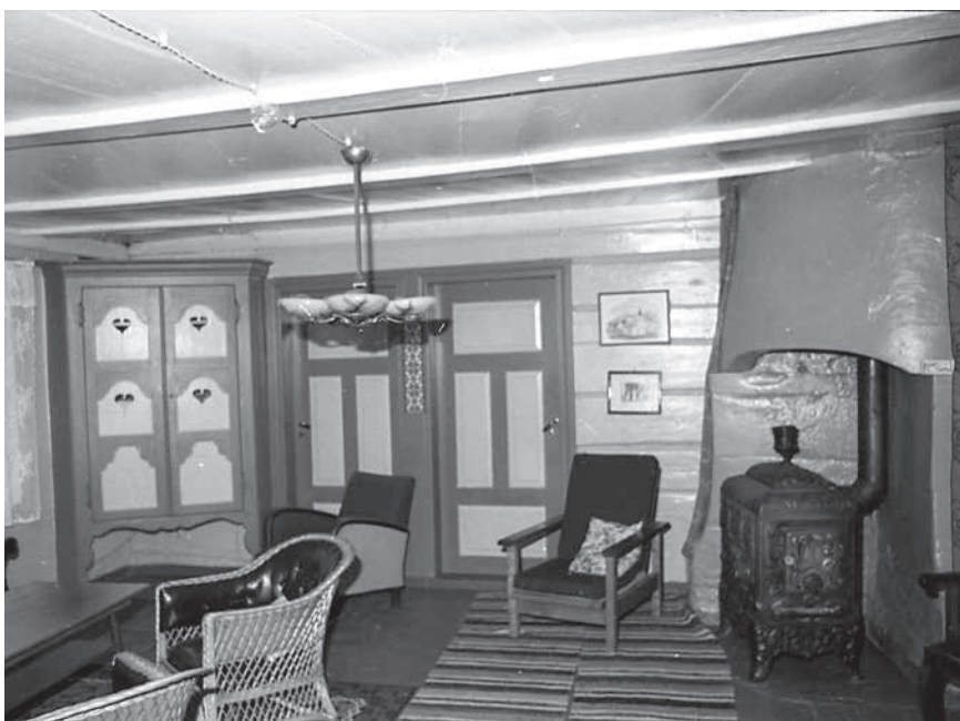
Frå Kyllingstua våren 1978, rett før rivning av huset. Inne i grua står «Bjønnonnen» som vart innsett i staden for århella i 1924.
