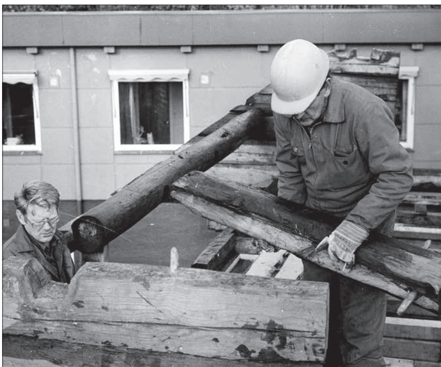
Frå gjenreisninga av Kyllingstua 1985. Peder Skotheimsvik står her med ein stokkende med to blindingar frå det huset vart bygd. I dette huset var meir enn hundre, kanskje to hundre slike blindingar, og alle hola var bora med husnavar.
