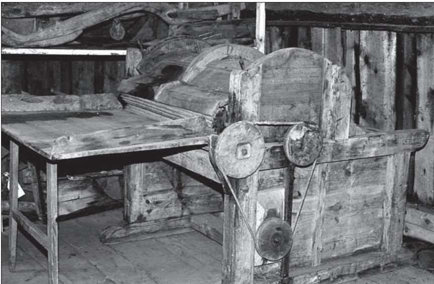
Heimlaga 'trøskemaskine' frå Horne, Eresfjorden. Somme brukte vasskraft, andre hestevandring til å dra slike maskiner. Den første maskina av denne sorten vart laga til Vorpenesgarden i 1842. Året etter vart det laga ei til sokneprest Bjørnson.
