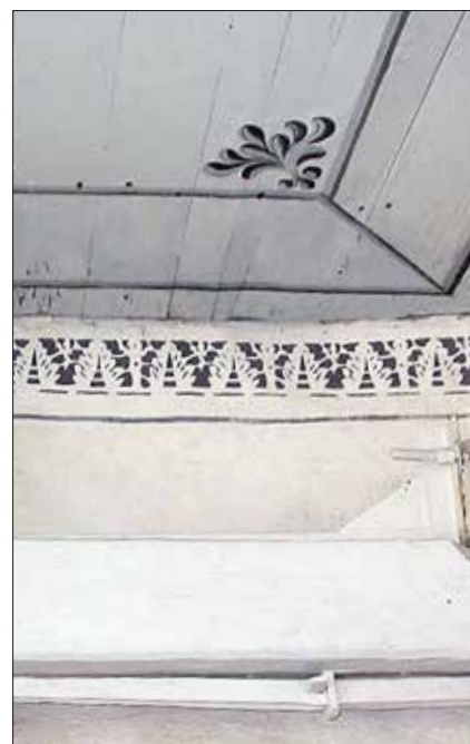
Sjablongmåling var på moten på 1800-talet. Det er truleg her Samseth har hatt bruk for «Kjørnrøk» og «Bensverte». Bildet er frå taket i nordvestre hjørne i kyrkja. (Romsdalsmuseets fotoarkiv)
