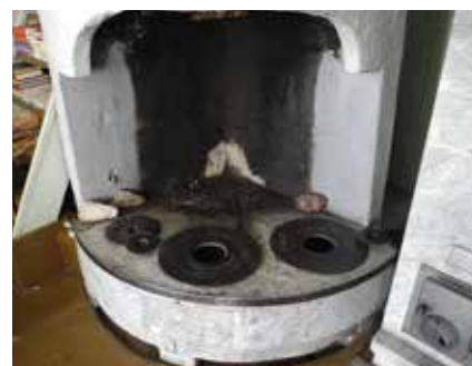
Århella på Stor-Kolstad er av kleberstein, og innlegget er litt bak t.h. Klebersteinsommen er sett inn seinare. (Foto 2013)
