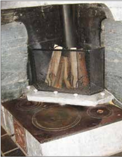
Århelle av malm med fyring på framsida. Her står ei omsnrøyr inst i grua slik at det kan fyrast under plata. Dette er frå Otta. (Foto Tor Einbu)
