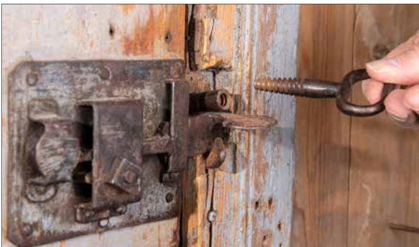
Dørlås med prysill. I kammersdøra i Vistdalsskulen på Romsdalsmuseet er det hol for prysillen. Prysillen stenger slik at klinka ikkje kan løftast. Ved å skrue 'nøkkelen' inn i prysillen kan ein ta denne ut slik at døra kan opnast.
