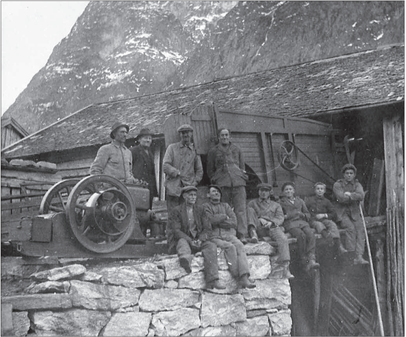
Eikesdal redskapslag («Trøskarlaget») kjøpte trøskarverk frå Edv. Bjørnrud i 1919. Til å dra verket kjøpte dei ein ein-sylindra Trygg-motor slik at dei slapp å bruke både hestevandring og vasskraft. Motoren er i dag på Gjermundnes landbruksmuseum. Bildet er frå ei trøsking i Utigard (bnr. 5) ca. 1926. Ståande f.v. Henning Østigård, Peder A. Oppigard, Edvard Utigard og Ingvald Kvisvik. Framme f.v. Torstein H. Oppigard, Ole A. Oppigard, Halvdan Østigård, Peder T. Utigard, Henry Finnset og Asbjørn Utigard. Verket var i bruk til ca. 1953, men dei siste åra vart det bruka elektrisk motor eller traktordrift. Foto Knut Finnset.
